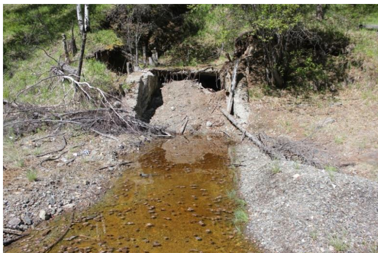
Рисунок 7. Вход в штольню «Капитальная» (место отбора пробы № 1 в июне 2021 г.)
