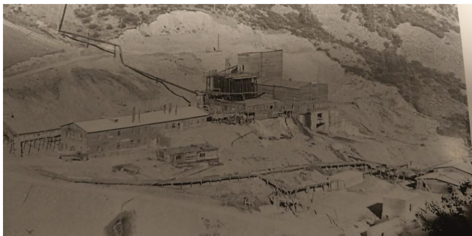
Фото 1. Промышленная площадка металлургического завода Терлигхайнского РЭП, 1973
